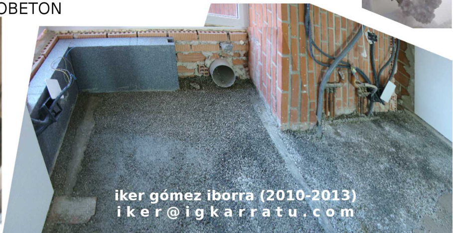
Fig. 6: El empleo de morteros técnicos, pruebas de trabajabilidad y suelo húmedo
